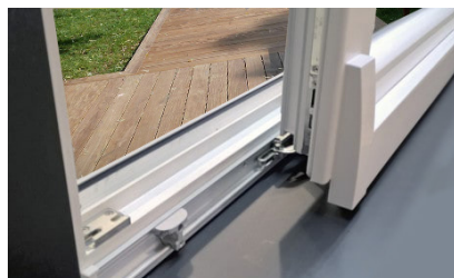
Roulements adaptés au poids du vitrage
